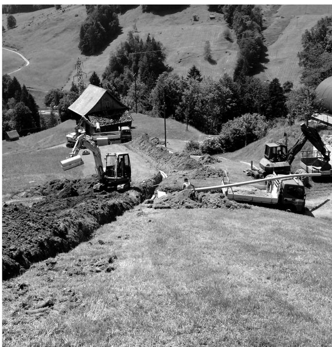
Leitungsbau Schwendenen: Neue Zuleitung 16kV in Hanglage
