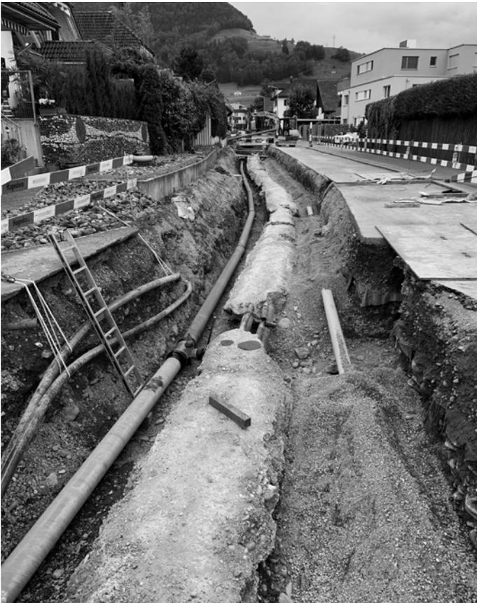
*Ersatz der Hauptwasserleitung an der Äusseren Bahnhofstrasse, Siebnen*
