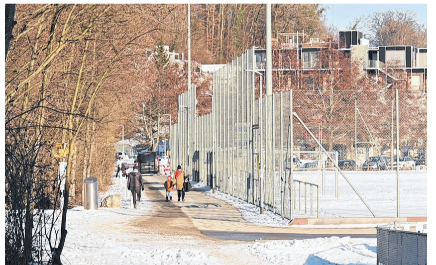
Die Zufahrtstrasse vom Erlenmoos zur Eishalle soll künftig verbreitert werden. Dazu müssen die Schwellen entfernt und die vier Kandelaber hinter den Zaun gesetzt werden.
