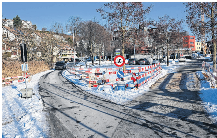
Die Einfahrt beim Erlenmoos soll verbreitert werden, sodass vor dem Rotlicht Autos kreuzen können. Dafür wird später die Notbrücke (rechts) entfernt. Bilder: Patrizia Baumgartner
